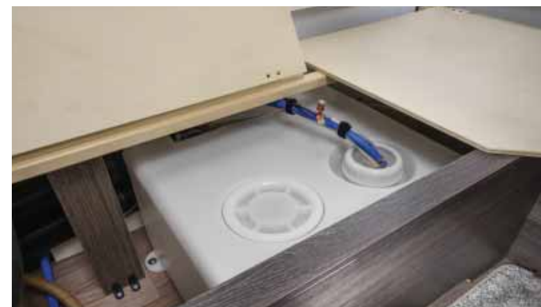
Schoonwatertank met afsluitbare tankdeksel en geïntegreerde overloop-/ leegloopaansluiting
