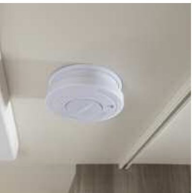
Rookmelder Optimaal geplaatst, waarschuwt in een vroeg stadium voor brandgevaar
